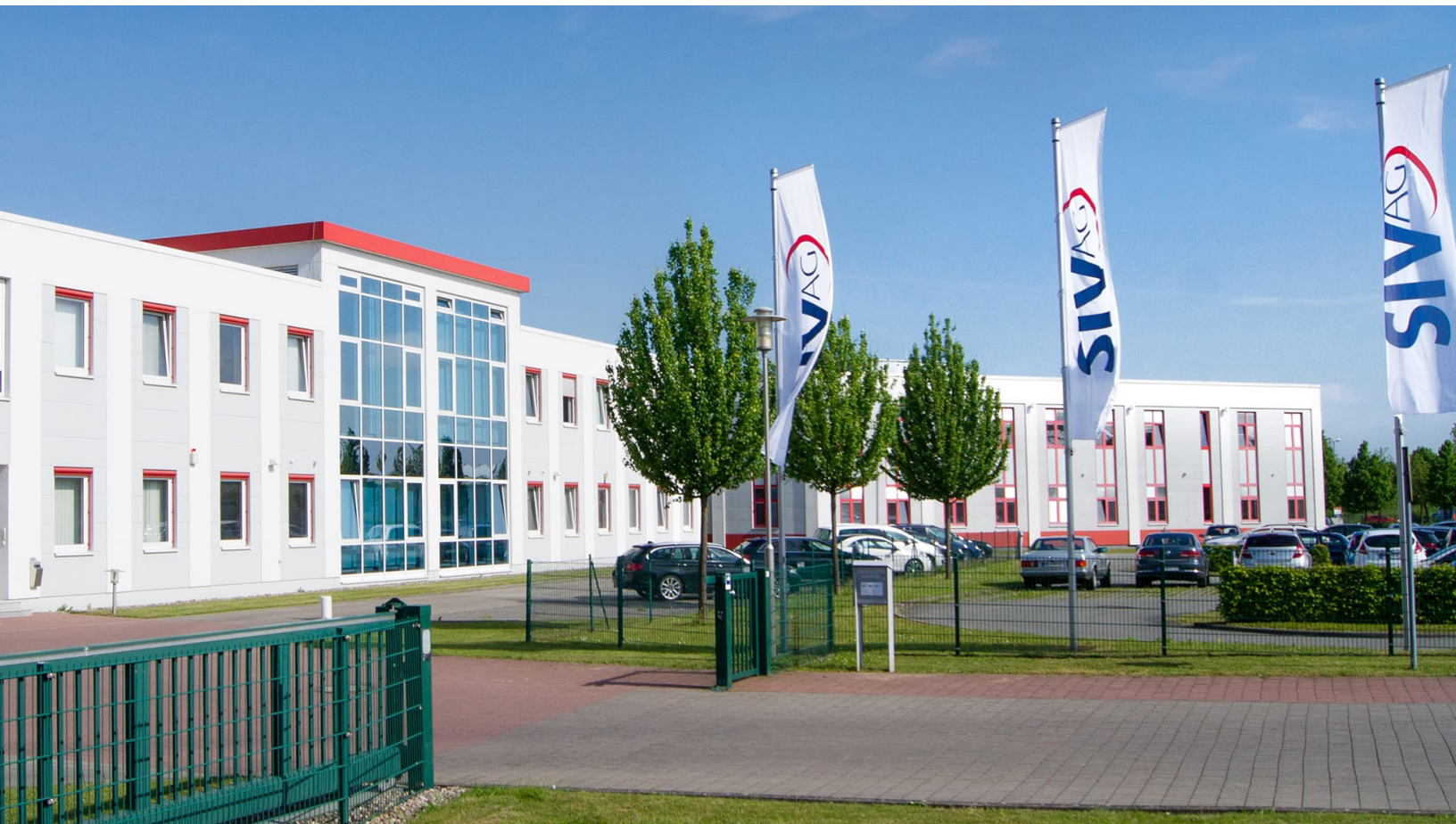
Bild: Unternehmenszentrale der SIV AG
